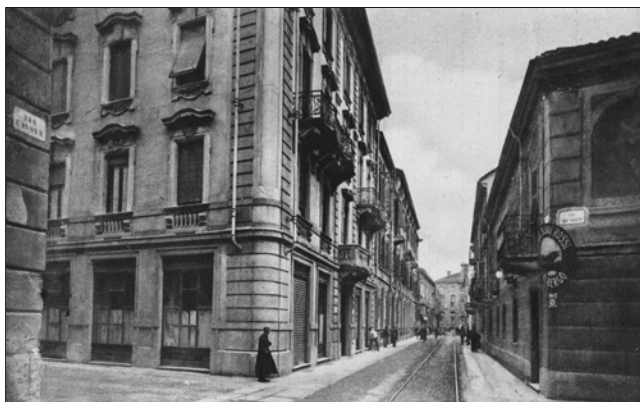
Ristorante Alli Due Buoi Rossi, via Cavour, 8 - Alessandria
